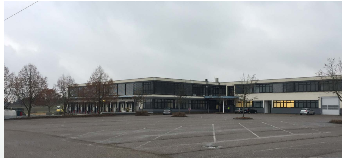
Neuer HTL-Standort in Durlangen.
